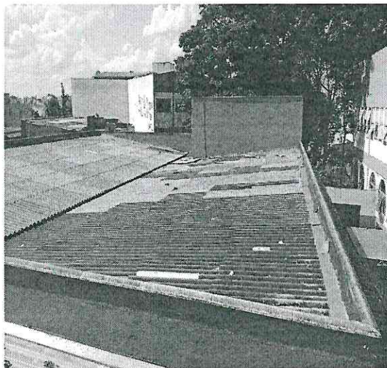
1. Vista do telhado (cantina e refeitório)
